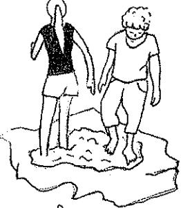
Εμείς χρησιμοποιήσαμε μίγμα από ένα μέρος πηλό (αγοράσθηκε καθαρός πηλός- χωρίς την ίλιο και την άμμο του πηλοχώματος, γιατί δεν είχαμε άμεση πρόσβαση σε πηλόχωμα), 2 μέρη κοκκινόχωμα και 2 μέρη άμμο οικοδομής.
